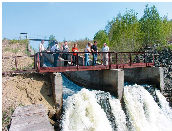
Рис. 6.1-1. Левобережный канал ТКВ
