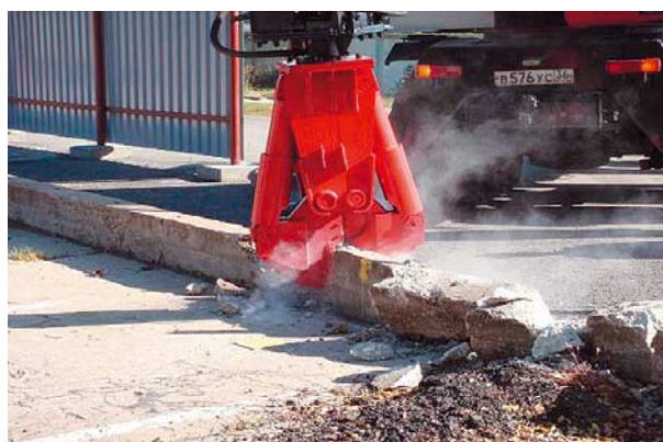
Рис. 2.5-2. Фрагментация бетонных конструкций гидравлическими ножницами
