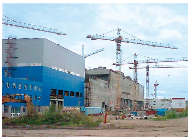
Рис. 3.2.1-1. Строительство сухого хранилища ОЯТ РБМК-1000
