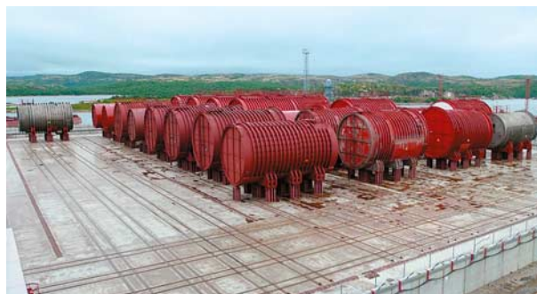
Рис. 6.2-2. Площадка сухого хранения реакторных блоков в губе Сайда
